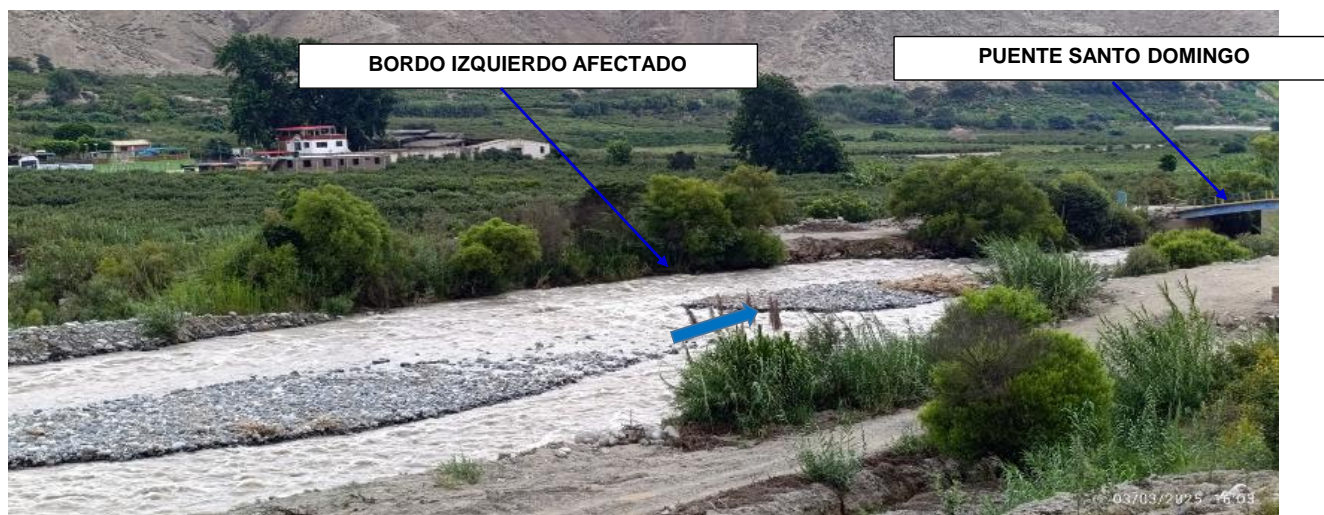
FIGURA N°03: MARGEN IZQUIERDA DEL RIO CHANCAY -HUARAL, AGUA ARRIBA DEL PUENTE SANTO DOMINGO, CON EL BORDE SOCAVADO POR EL CAUDAL, PONIENDO VULNERABLE AL PUENTE Y AL CENTRO POBLADO DE SANTO DOMINGO.
