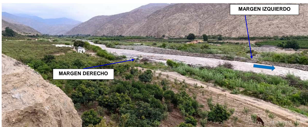
FIGURA N°04: MARGEN PANORAMICO DEL RIO CHANCAY -HUARAL, TRAMO CRITICO SANTO DOMINGO, CON EL BORDES SOCAVADO POR EL CAUDAL
